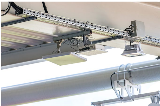
Outdoor Access Point LANCOM OX-6400 mit Sektorantenne AirLancer ON-Q30: Hoch oben in der Stadionüberdachung positioniert, sorgt diese Kombination für eine flächendeckende und leistungsstarke WLAN-Versorgung auf den Tribünen des Heinz-Steyer-Stadions. Bildrechte: Sandra Hofmann
